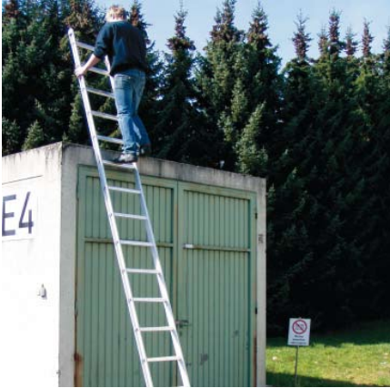
Bild 40: Übersteigen von Anlegeleiter
