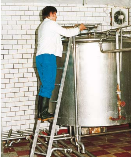
Bild 31: Leiter mit Einhängenvorrichtung am Behälter
