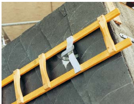
Bild 20: Dachdeckerauflegeleiter
